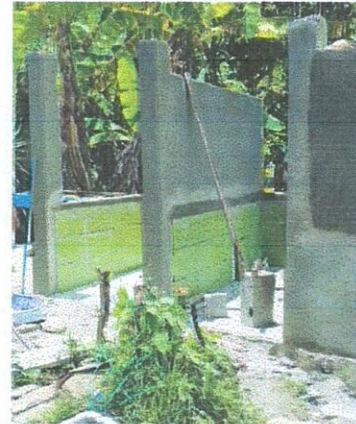
Foto 4: Avance de la construcción de los sanitarios
