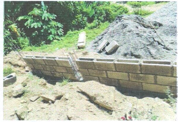
Foto 2: Avance del Cerramiento perimetral
