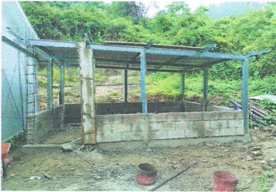
Foto 3: Cocina en proceso de construcción
