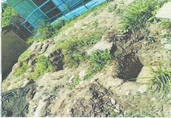
Foto 1: Inicio de Zanja para el cerramiento perimetral
